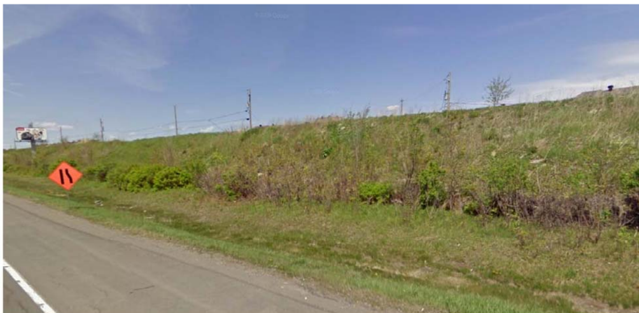
Autoroute 15 à Laval
